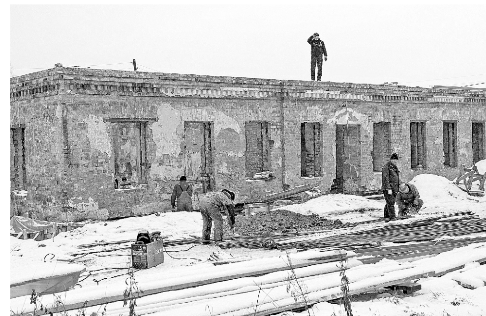
2016 год. Монтаж новых перекрытий
